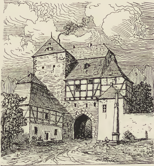
Fig. 166. Leisnig, Oberthor. Zustand vor dem Abbruch.
